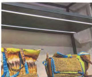
LED-Streifen zur Warenbeleuchtung, im Fachboden eingelassen
