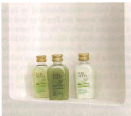
Die Nischen der Wandverkleidungen sind gegossen und damit absolut fugenlos
