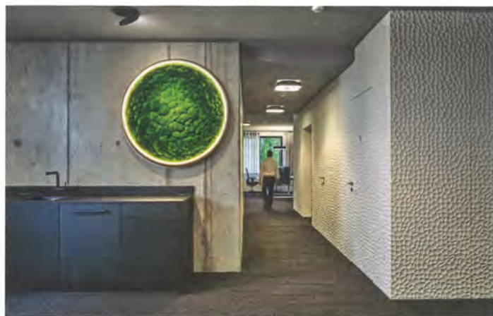
/ Mit 3D-Fräsuren wurde das Reliefmuster aus dem Mineralwerkstoff Varicor herausgearbeitet. Die einzelnen Platten sind fugenlos miteinander verbunden.
